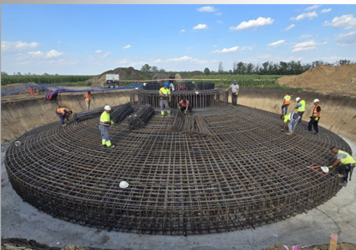
VESTAS V162 : 99,2 MW
